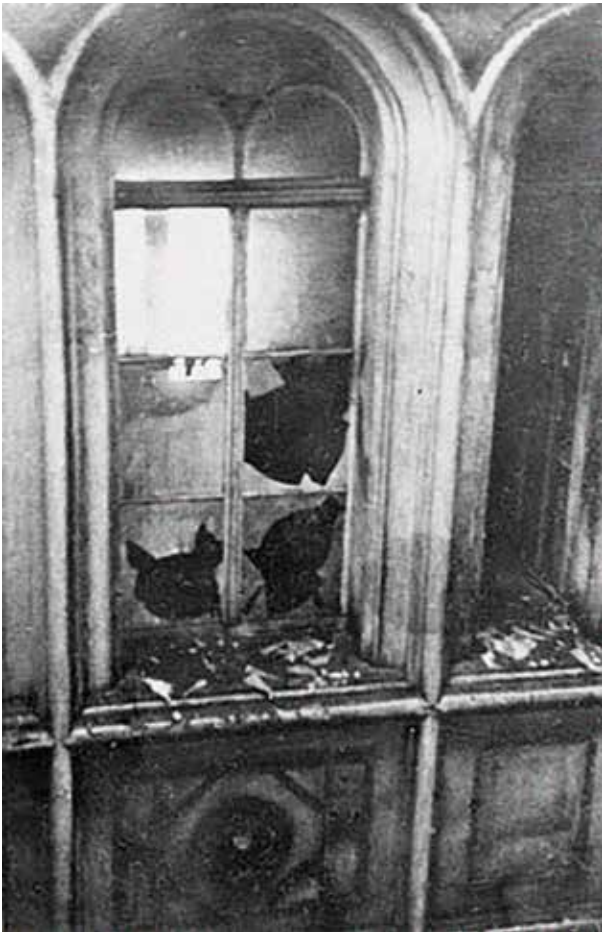
Zerstörte Synagoge, Große Schiffgasse, Wien-Leopoldstadt (DÖW Foto 8393) – 2/32
