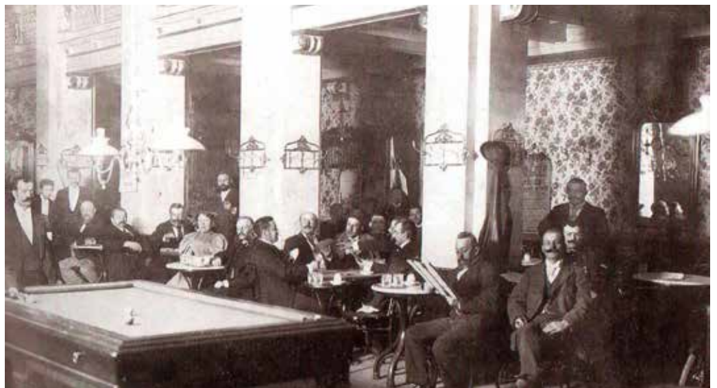
Innenansicht. Aufnahme aus 1896. Quelle: Wien-Landstraße – ein Bilderbogen, Archiv Christoph Römer
